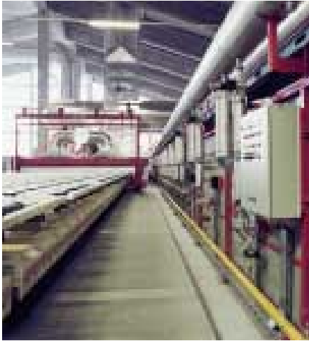
Four tunnel (société Keller)
