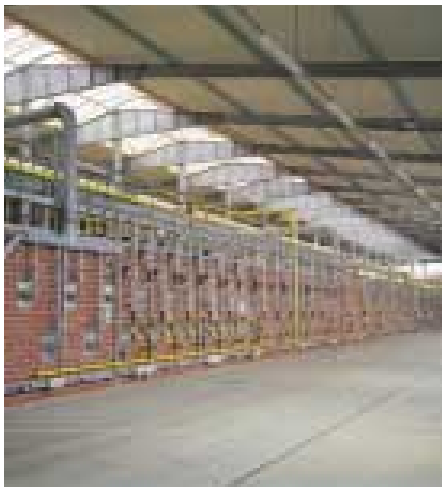
Four tunnel (société Keller)
