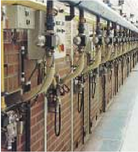
Four tunnel (société Instalat)
